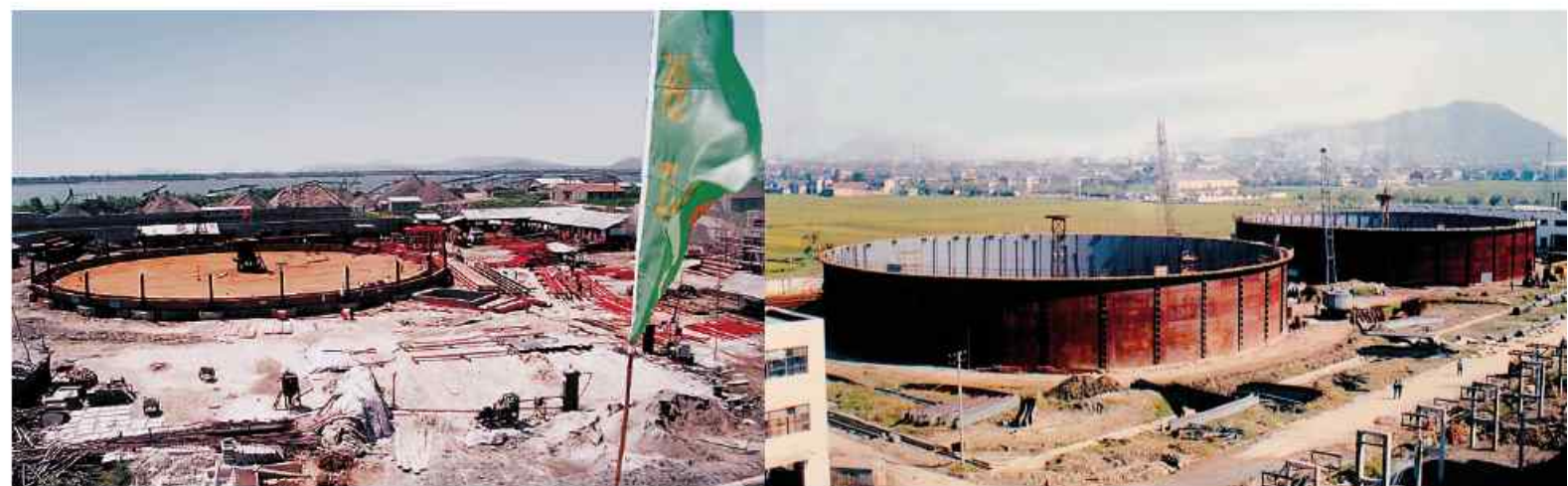
▲ 正在建设中的杭州煤制气厂储气罐
