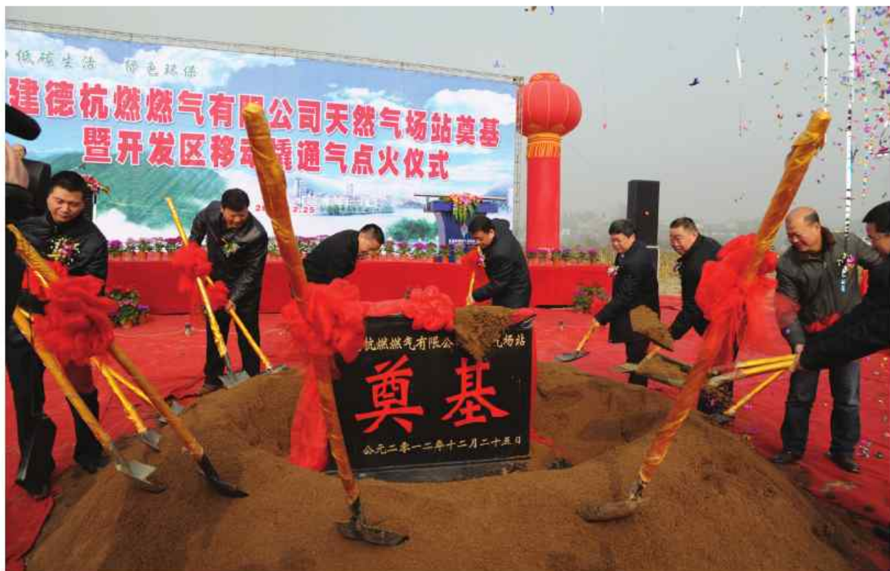
▼ 2012年1月25日建德天然气场站开工建设。
