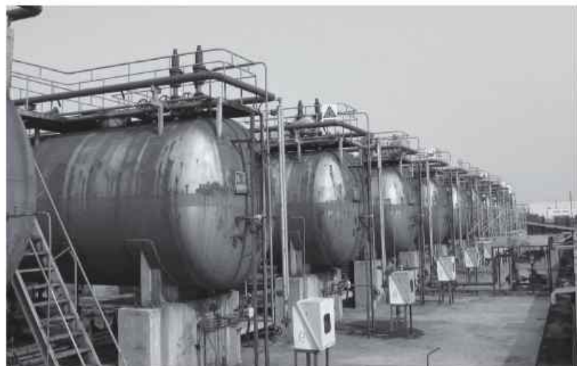
▲位于瓜山的杭州煤气公司第二灌装场
